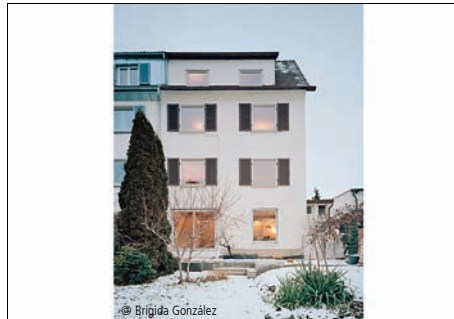
6100-1329 Reihenendhaus Modernisierungen; Ein- und Zweifamilienhäuser vor 1945 AMUNT Nagel Theissen Architekten und Designer PartG mbB, Stuttgart
