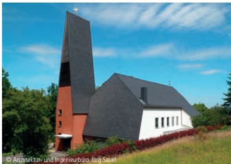
9100-0132 Kirche Instandsetzungen; Nichtwohngebäude ☐ Architektur- und Ingenieurbüro Jörg Sauer Hildesheim
