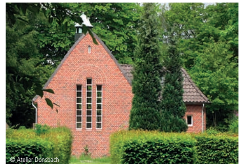
9100-0138 Veranstaltungsraum, ehem. Friedhofskapelle Instandsetzungen mit Restaurierungsarbeiten ☐ Atelier Dönsbach Hamburg
