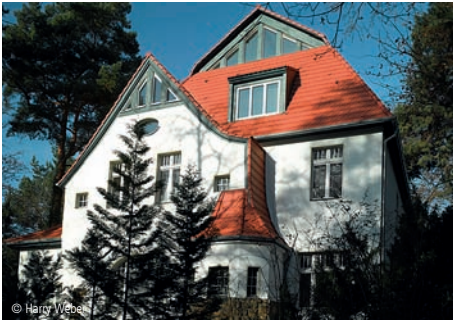
6100-1286 Mehrfamilienhaus, Dachgeschoss Erweiterungen; Wohngebäude: Dachausbau rundzwei Architekten Berlin
